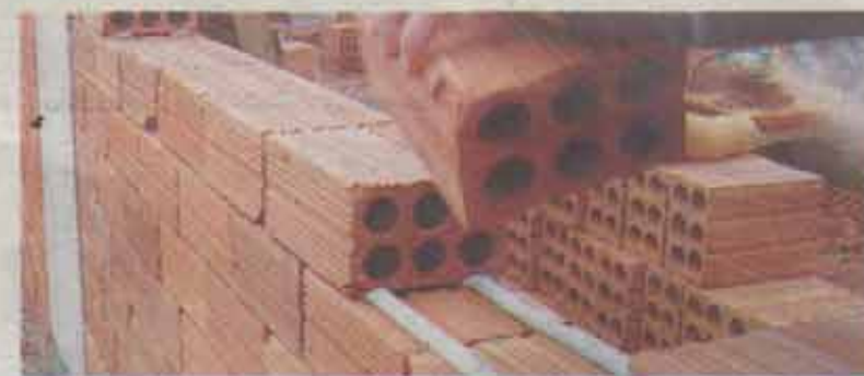
Segundo a informação do produto, uma embalagem de 15 quilos de massa Dundun é suficiente para assentar 10 metros quadrados de parede, representando menos de cinco por cento da quantidade de material que seria necessário com o método tradicional. Fonte: www.massaadundun.com.br .
